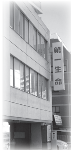
第一生命保険(株) 渋谷支社世田谷中央営業オフィス
